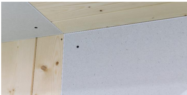
Abbildung 5: Schmitt-Laibungselement mit Anschlussprofil Übergang zur Holzdecke
