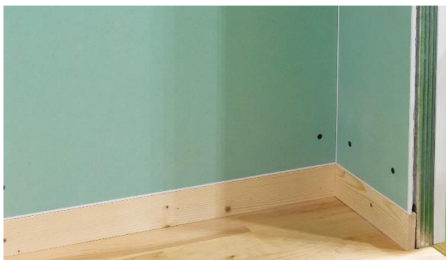
Abbildung 6: Schmitt-Laibungselement mit Anschlussprofil zurückversetzter Sockel
