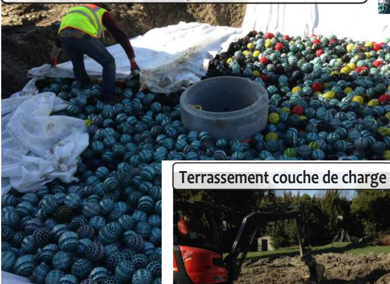
Fermeture du géotextile
